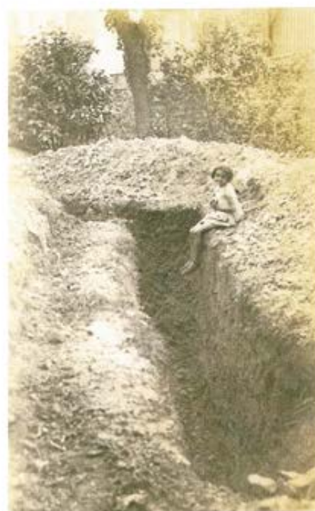
les tranchées à Donville
