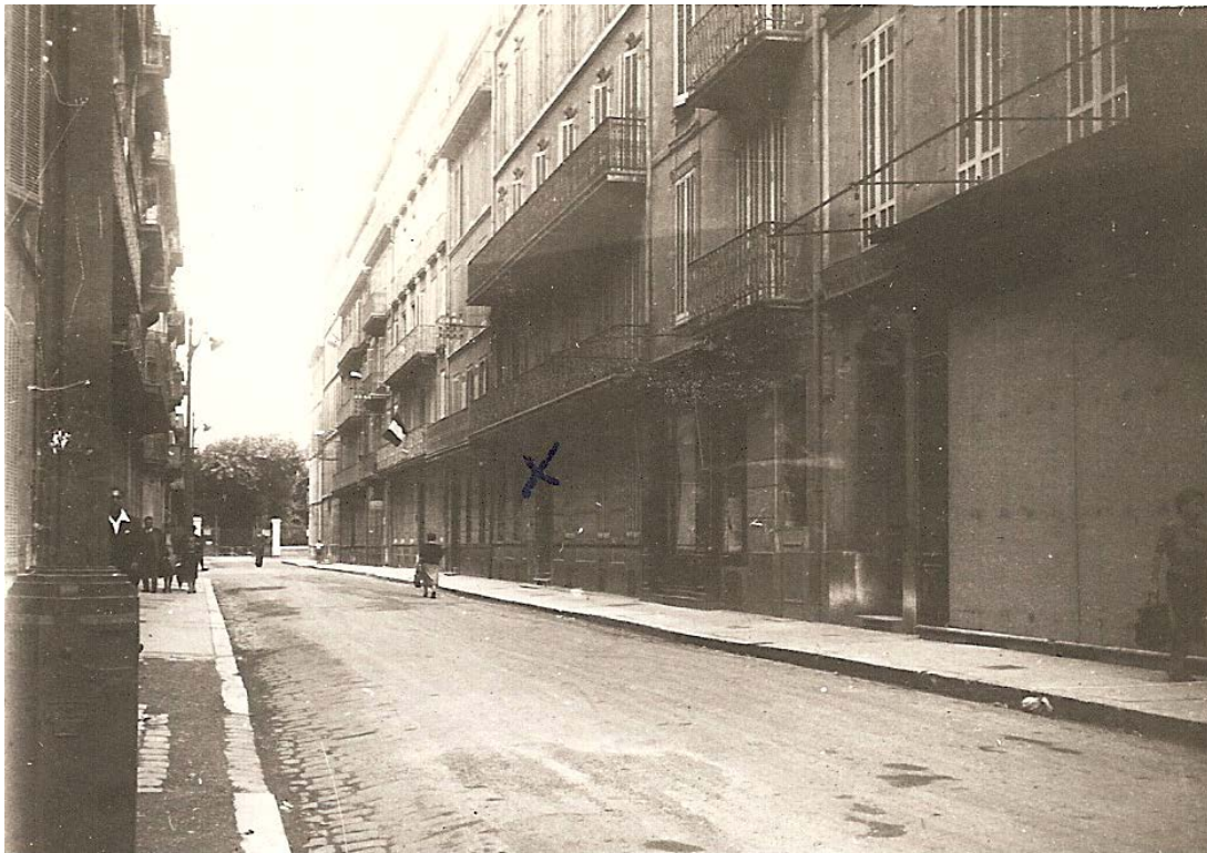
Le 14 rue Peirese avant le bombardement du 24 novembre 1943
