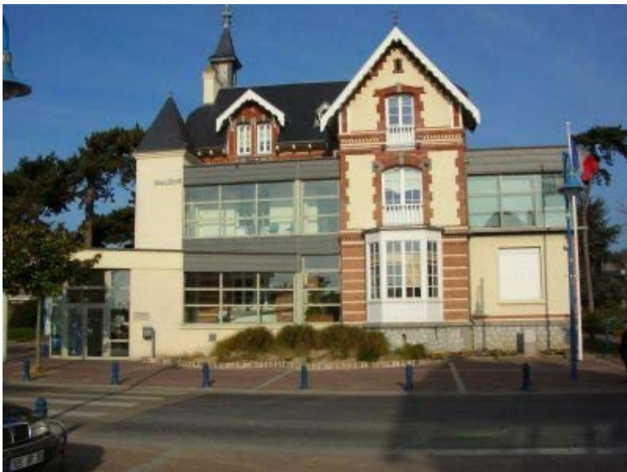
L'ex-Villa Louise devenue la mairie de Donville-les-Bains
