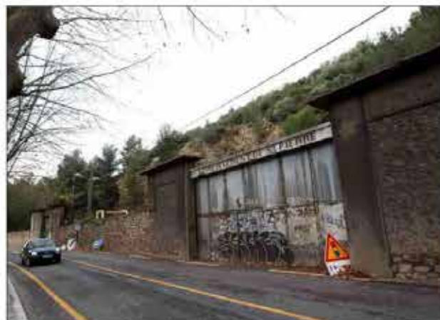
Depuis les violents combats de la Libération, le site des Établissements Saint-Pierre, route du Revest, n'a jamais révélé tous ses secrets.
