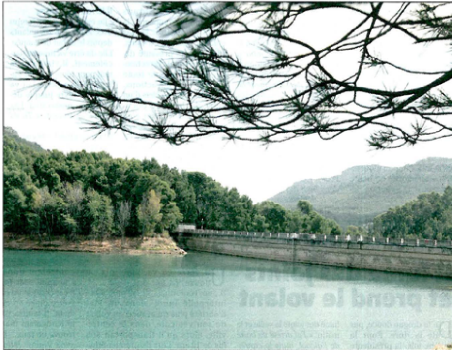
Le barrage du Revest forme un arc de cercle et mesure 175 m de long. Il a été construit en 1912 et appartient à la ville de Toulon. (Photo Patrick Blanchard)
