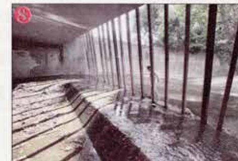
Rivière Neuve : le Las sous buse
