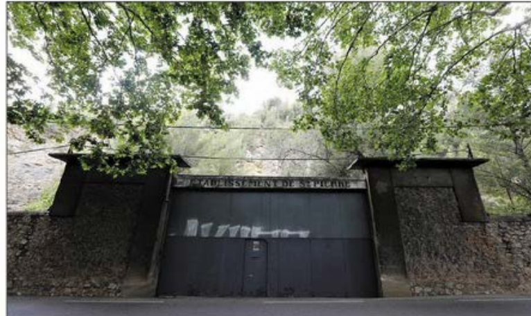
Lors des combats qui ont conduit à la libération de Toulon, en août 1944, une des quatre galeries de la poudrière des Moulins s'est effondrée et les soldats allemands qui l'occupaient ont été ensevelis sous les décombres.
